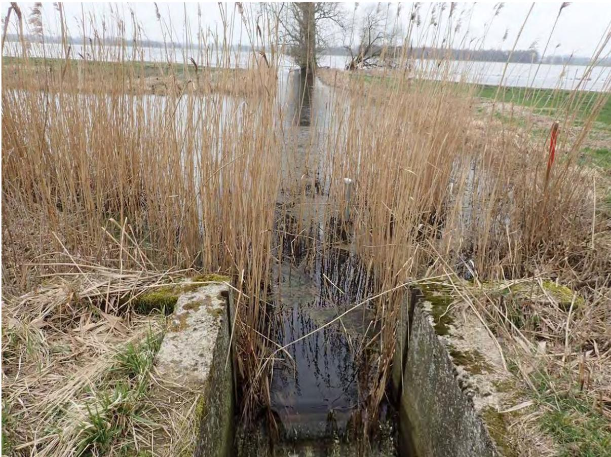
**Abbildung 93: Der Pumpensumpf am 21.03.2019: Das am Zulauf zum Schöpfwerk installierte Staubrett wird überströmt. Der Wasserstand im Pumpensumpf ist mit den Wasserflächen im ehemaligen Duvensee ausgepegelt.**
